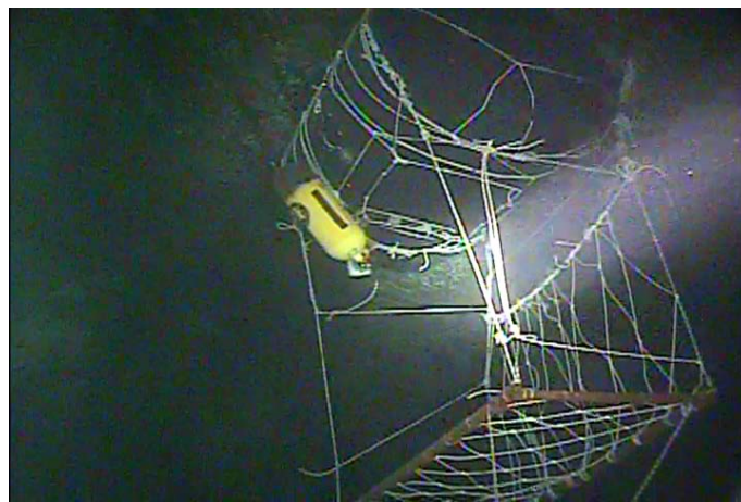
Ο κώδωνας όπως είναι τοποθετημένος στα -10 μέτρα βάθος. Δεξιά της κίτρινης φιάλης διακρίνεται η είσοδος κάτω από την οποία είναι κατασκευασμένη από μεταλλικό πλαίσιο και δίκτυο η εξέδρα.
